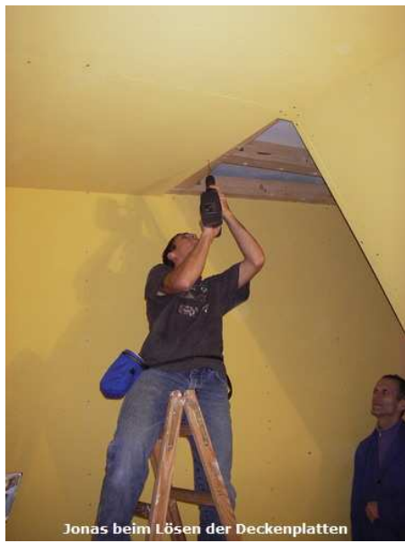
Jonas beim Lösen der Deckenplatten
