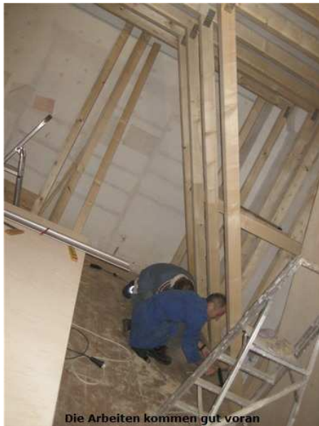
Die Arbeiten kommen gut voran
